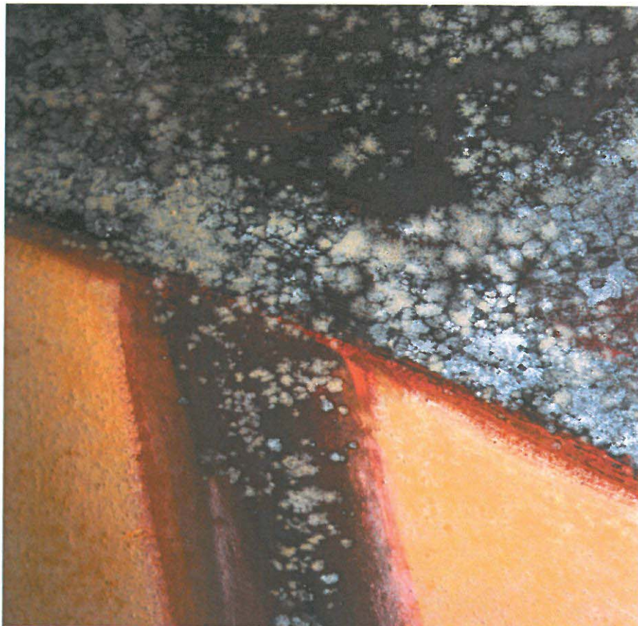
Die Deckenfrescos sind vom Schimmelpilz befallen.
