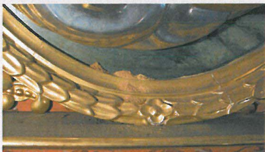
Holzwurmschäden an den Altären.
