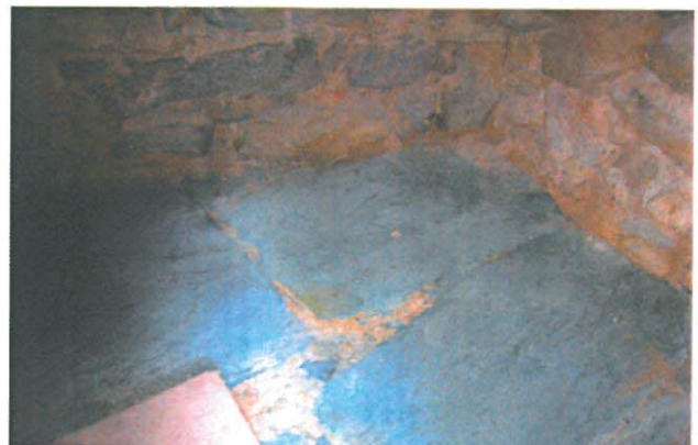
Foto oben rechts: Probeweise ausgehobener Sickergraben zum Untersuch der Fundamentmauern.
