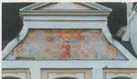
Fassaden-Fresken durch Sonnenbestrahlung stark verblichen.
