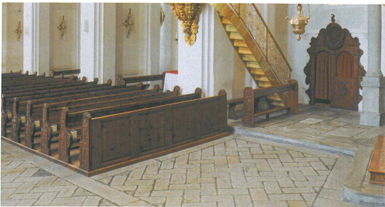
Natursteinboden, verfügt, mit Salzablagerungen
