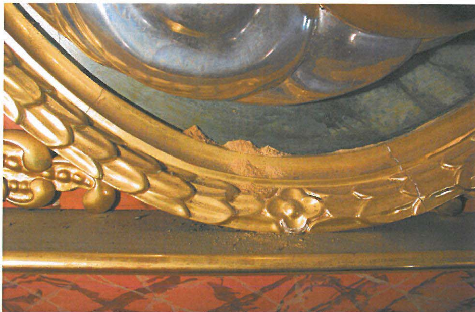
Holzwurm-Schäden an Altären
