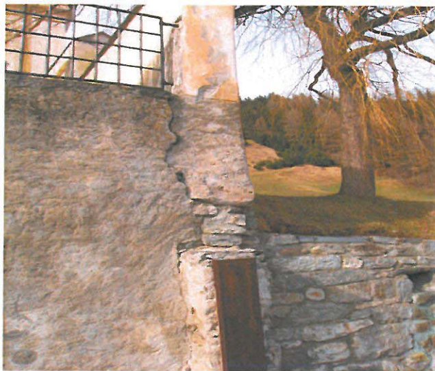
Sanierungsbedarf bei der Stützmauer
