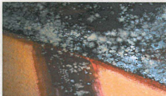
Decken-Fresken sind von Schimmelpilz befallen.
