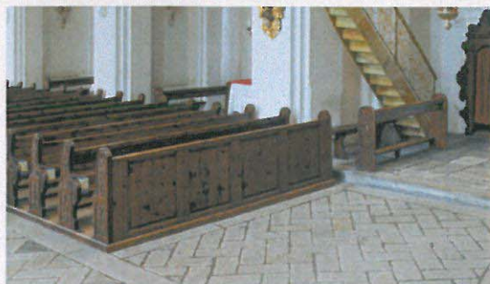
Verfugte Granitplatten direkt auf Erdboden.
