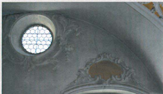
Staub- und Schmutzschichten, Risse im Gemäuer.
