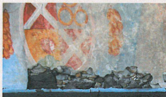
Umfangreiche Frostschäden an der Südfassade
