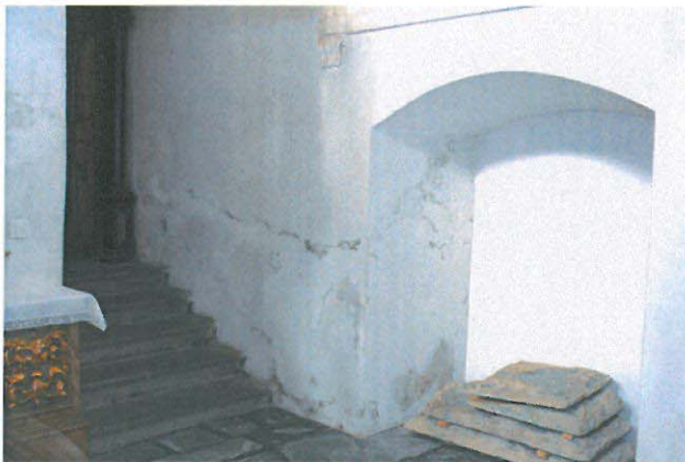
Foto oben Links: Aussenwand mit sichtbaren Spuren von Feuchte- und Salzs Schäden.
