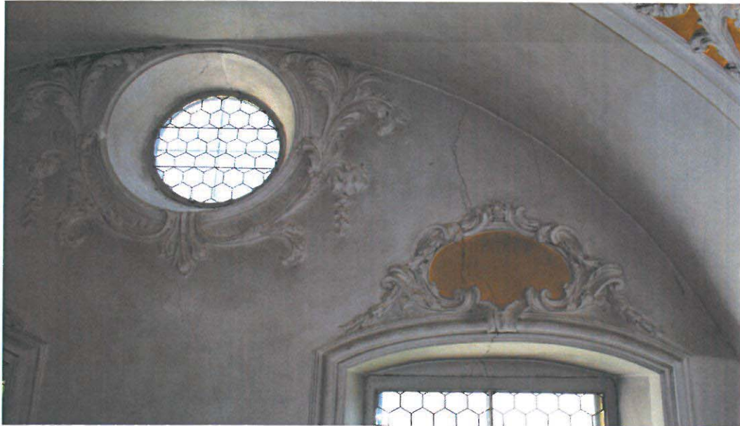
Staub- und Schmutz-Schichten, Risse im Gemäuer
