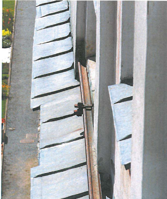
Süd-Fassade: Die Stabilisierung mit Eisenbahnschienen wird erneuert.
